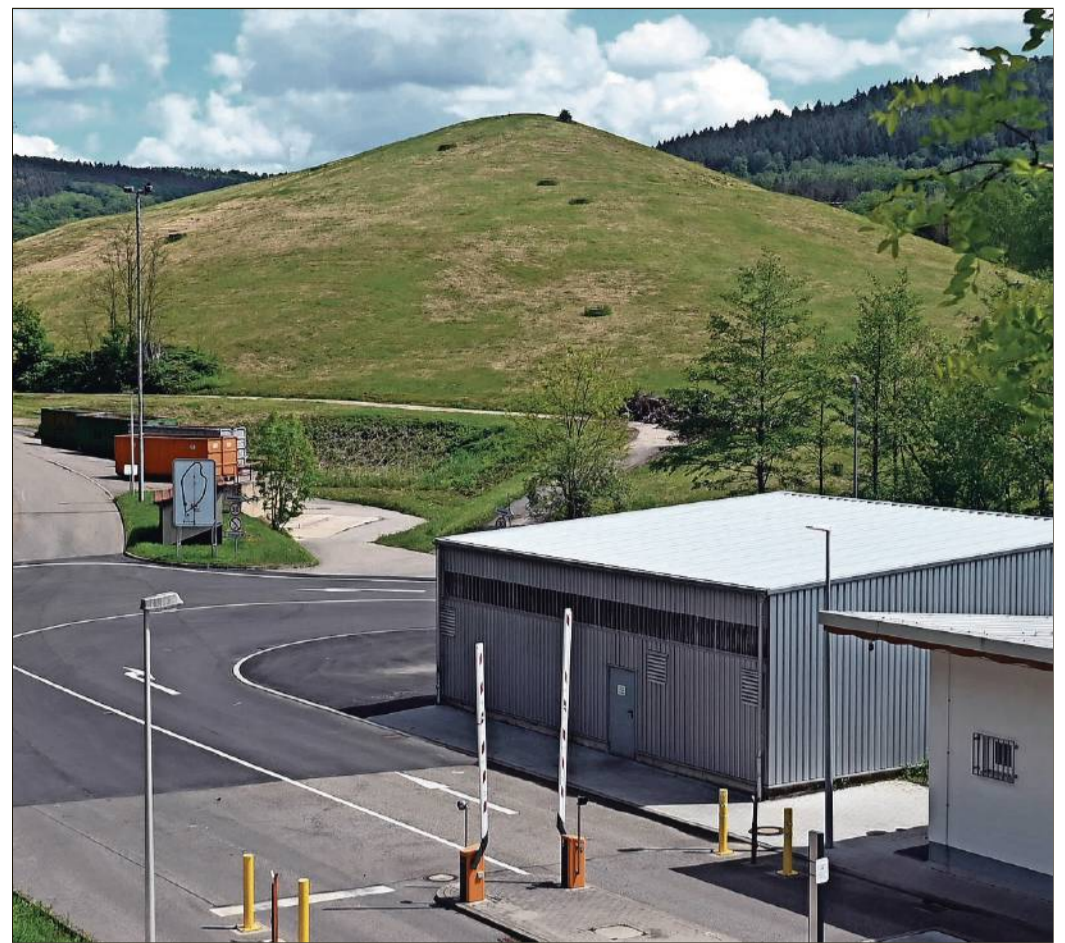
Auf dem zentralen Deponiekörper liegen bereits 330.000 Tonnen PFC-haltiger Müll aus der Papierindustrie. Dort soll ein Abschnitt für PFC-haltigen Bodenaushub entstehen. Foto: dpa
