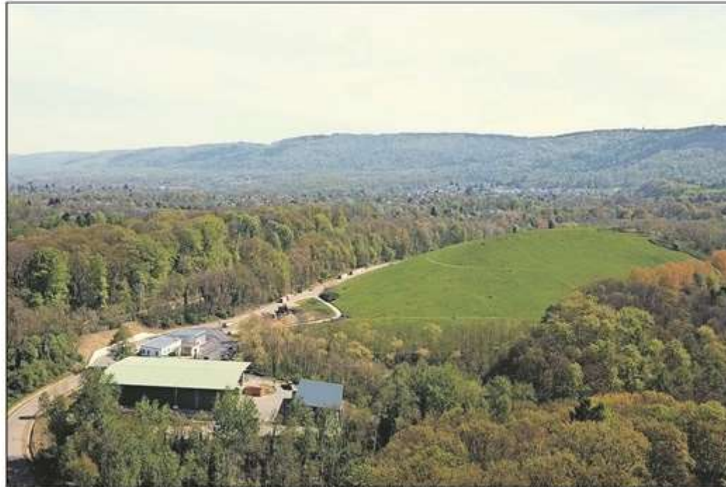
Auf der Deponie in Oberweier soll künftig PFC-haltiger Erdaushub abgelagert werden. Unter anderem dagegen wendet sich eine Bürgerinitiative.
