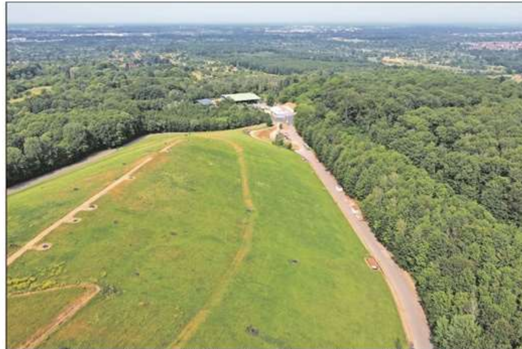
Der Zentralbereich der Deponie Oberweier. Pläne zur dortigen Ablagerung PFC-haltigen Erdaushubs werden nicht mehr verfolgt. Die Anlage gilt als Sanierungsfall. Foto: Archiv
