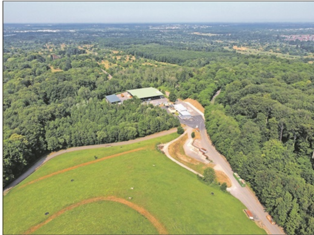
Die Deponie Hintere Dollert Oberweier im Juni 2021. Knackpunkte einer neuen Pachtvereinbarung sind laut AWB Rechte und Pflichten beider Parteien.
