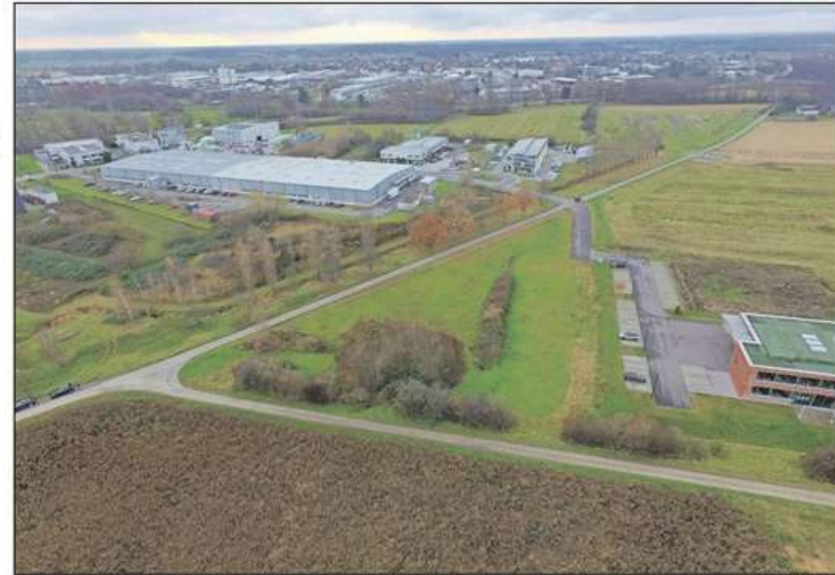
Sanierungsfläche: In den Bußmatten wird mit PFC belastetes Bodenmaterial aus Balzhofen und dem Vimbacher Klärwerk zwischengelagert und dann eingebaut. Foto: Bernhard Margull
