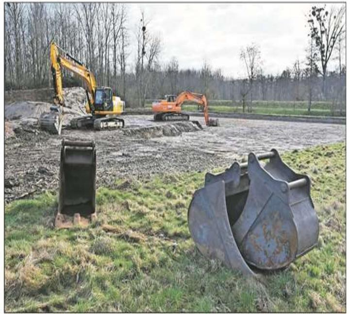
**Auf einem Feld in der Nähe des Wasserwerks Balzhofen graben Bagger PFC-verunreinigten Boden ab.**
