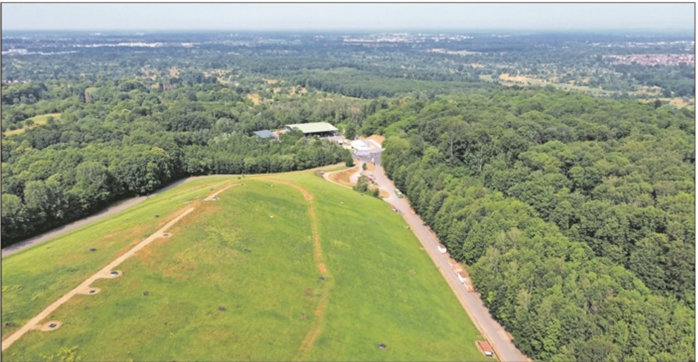
Zentralbereich der Mülldeponie: Die zunächst geplante Erweiterung zur Ablagerung von PFC-haltigen Abfällen führte zur Gründung einer Bürgerinitiative. Foto: Peter Kraft / Archiv
